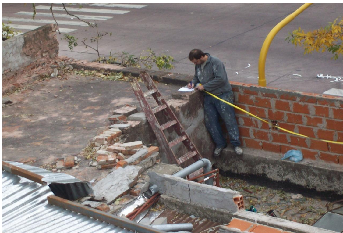
Restos del techo (Caído al revés: se ven las vigas torcidas y/o partidas)
